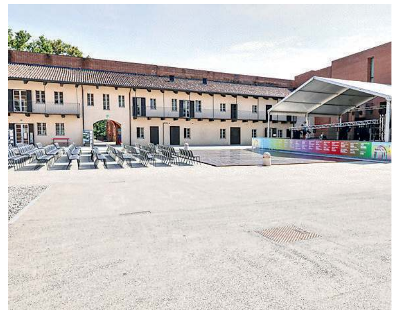
La nuova pavimentazione nel cortile del castello
