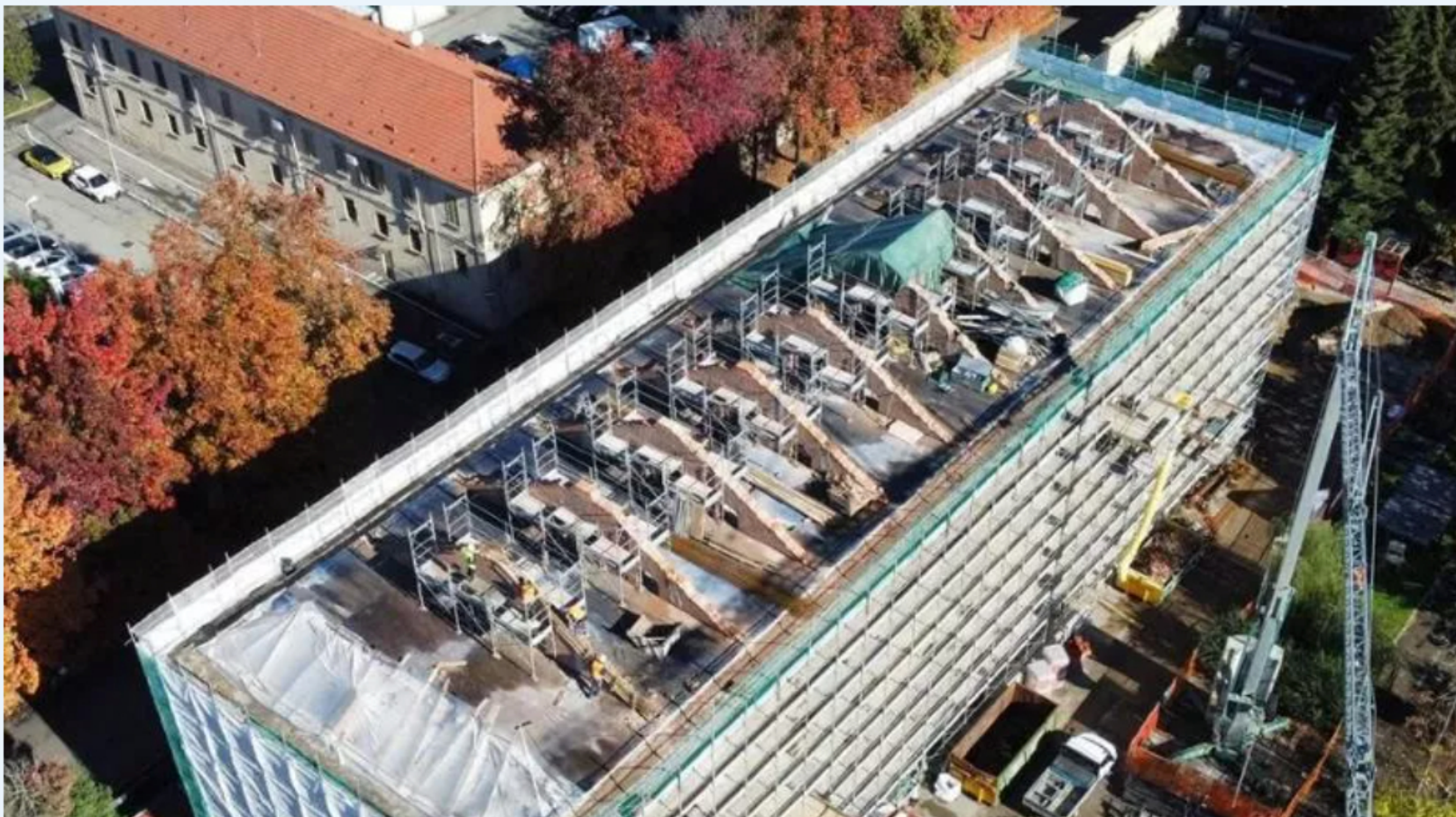
I lavori al tetto dell'ex caserma Passalacqua che ospita Nòva
