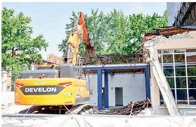
I lavori ieri mattina di demolizione a Nòva
