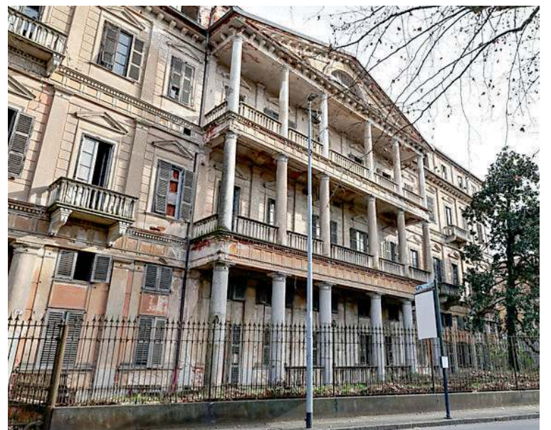
Casa Bossi ancora in attesa dei lavori di ristrutturazione
