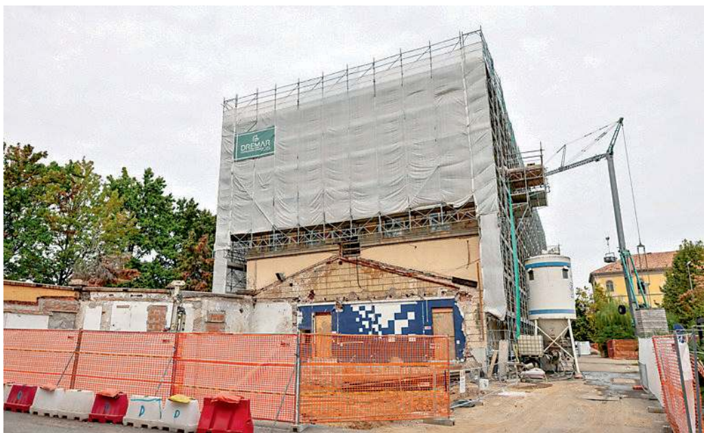
Il cantiere dello spazio Novà nell'ex caserma Passalacqua a Novara
